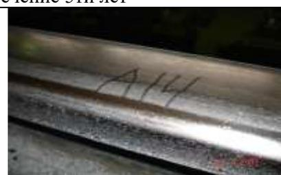
Состояние подкранового пути через полтора года после установки систем смазки (равномерное заполнение контактной поверхности смазкой)
