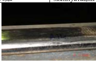
Состояние подкранового пути через четыре месяца после установки систем смазки (выравнивание поверхности, отсутствие задиров)
