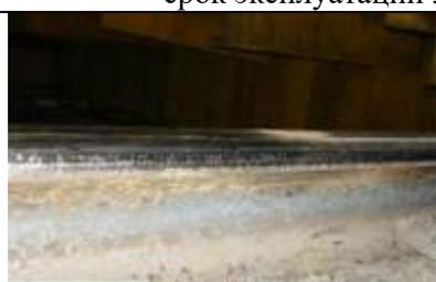
Состояние подкранового пути до установки систем смазки (задиры, коррозия)
